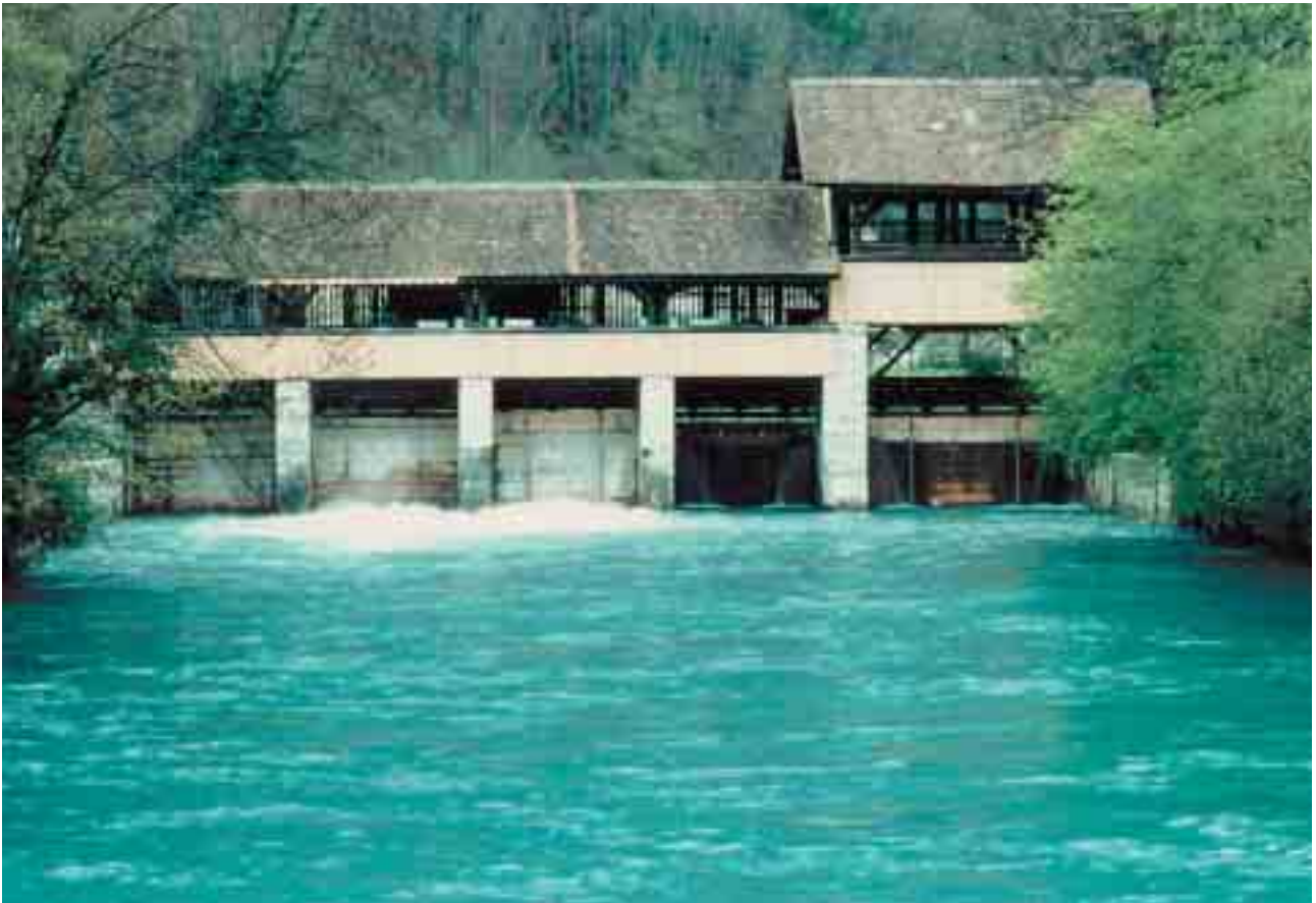
Fig. 177 Régularisation du lac de Brienz. Vue des «écluses supérieures». Ce barrage de régularisation équipe le bras gauche de l'Aar à Interlaken. Doté de vannes levantes en bois, il a été mis en service en 1856 et remis à neuf à plusieurs reprises. Vue vers l'amont de l'Aar. Photo B. Etter, 1994.
