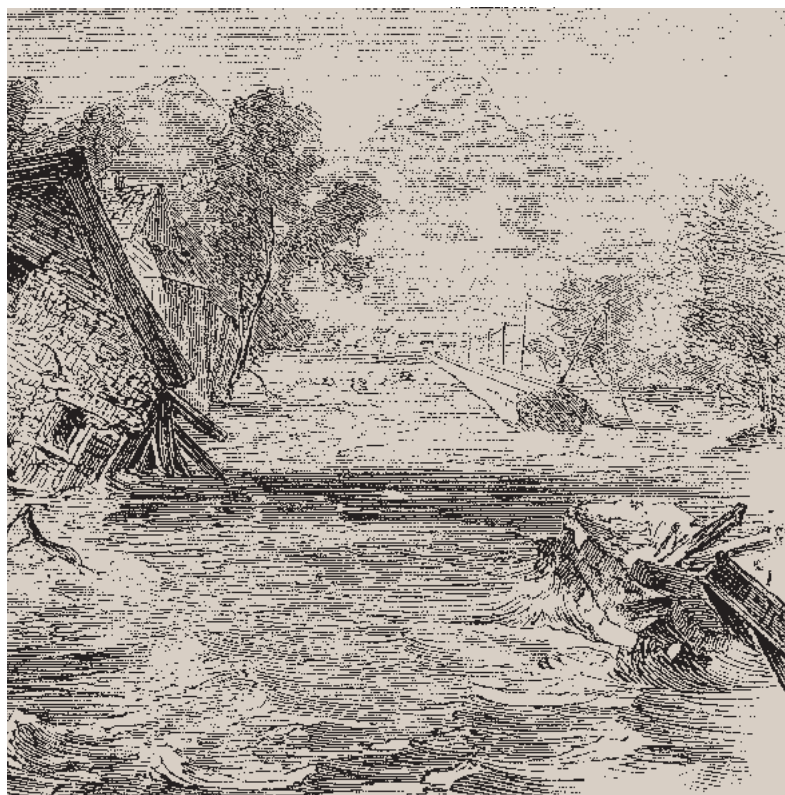
Fig. 200 Les crues de 1868, qui touchèrent une grande partie de la Suisse, exercèrent une influence déterminante sur la politique fédérale et cantonale en matière de protection contre les crues. Cette illustration du Rheintal montre des dégâts aux bâtiments à Burgerau près de Buchs, mais aussi que la ligne ferroviaire, construite en 1858, et la ligne télégraphique ont été coupées.
