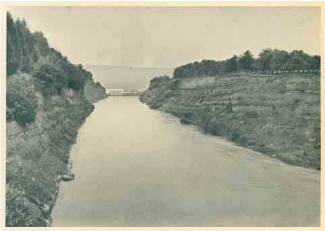
Fig. 104 La coupure de Hagneck vers 1900, vue dans la direction de l'écoulement. On aperçoit au fond le barrage de la centrale électrique de Hagneck, construite de 1897 à 1900 sur la rive du lac de Biene.
