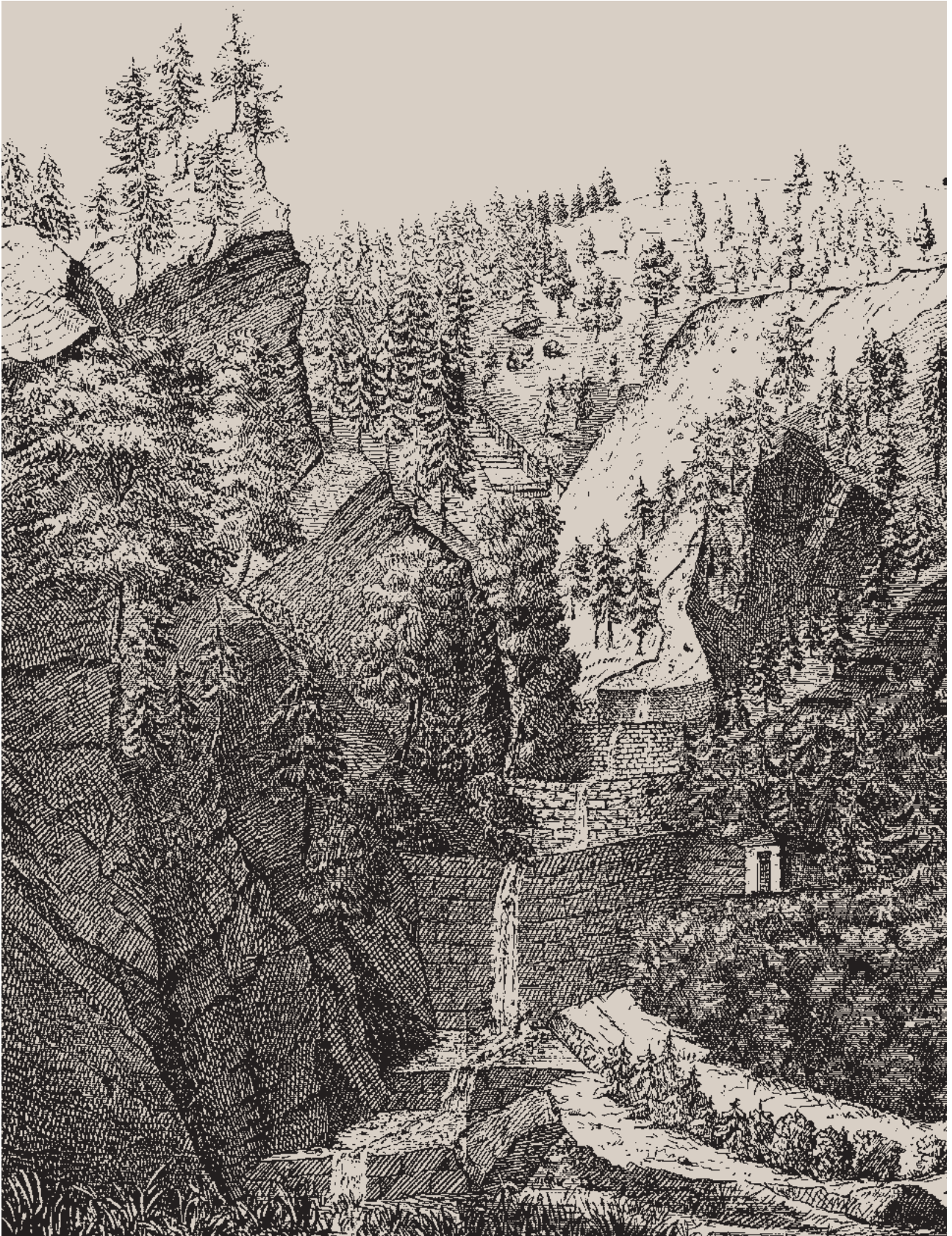
Fig. 159 La Rûfirunse à Mollis. Vue de la cascade de barrages construite à partir de 1842. Dessin de G. H. Legler, 1868.
