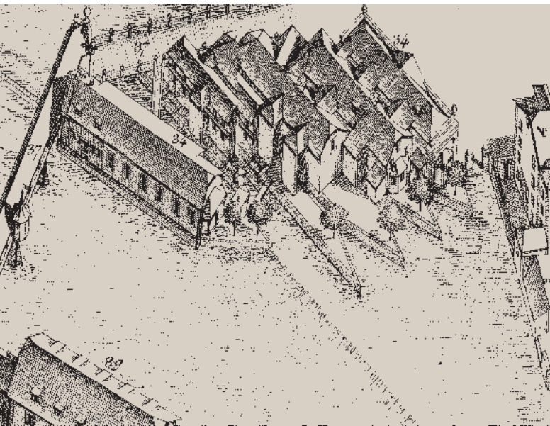
Fig. 181 Les moulins de la ville de Lucerne. Extrait d'une perspective de F. X. Schumacher, 1792.
