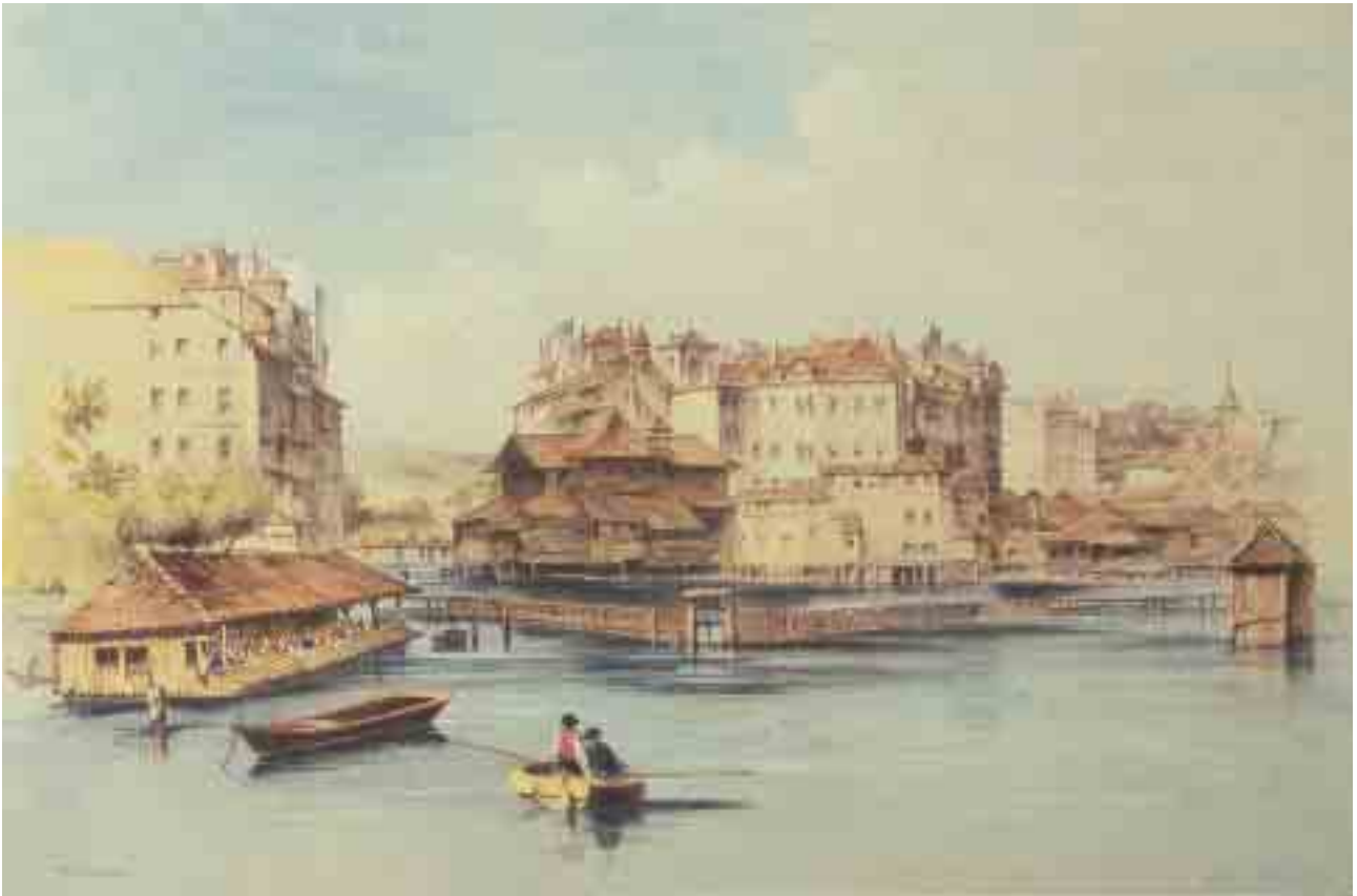
Fig. 191 La Machine hydraulique de Genève (construction en bois du milieu) porte la date 1837 dans l'illustration. Elle comprend encore pour l'essentiel les machines construites par J. Maritz. Vue vers l'aval du Rhône. L'encombrant bâtiment, adossé à l'île, entrave notablement l'écoulement dans le bras gauche du Rhône. A gauche se trouve un bateau-lavoir.
