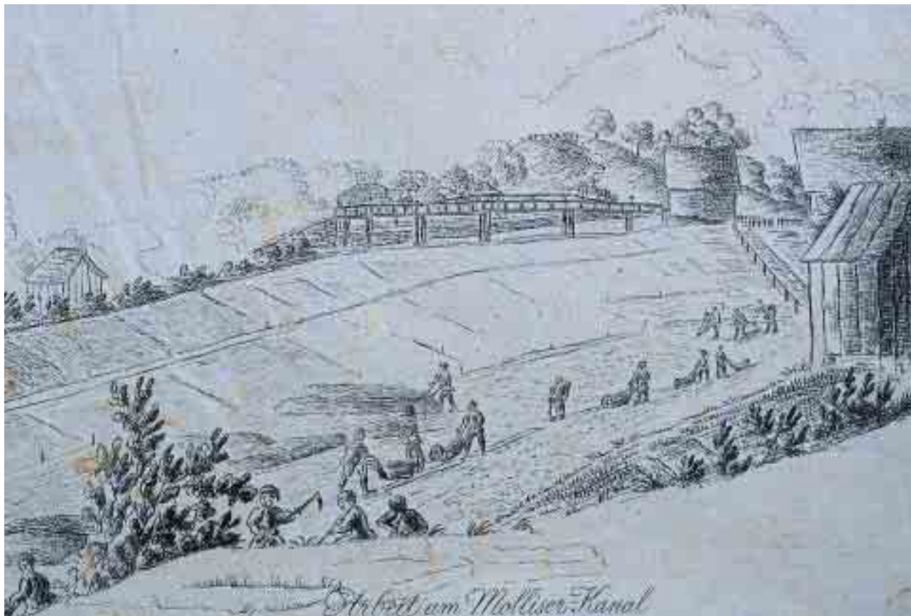
Fig. 78 Travaux sur le canal de Mollis. Le dessinateur pourrait être K. Schindler, le fils de Conrad Schindler.
