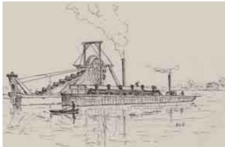
Fig. 46 Drague à godets actionnée à la vapeur, avec un bateau de transport à fond ouvrant arrimé, dans le canal navigable d'Interlaken, vers 1900 (repris en 1891 dans le parc d'engins de la correction des eaux du Jura).
